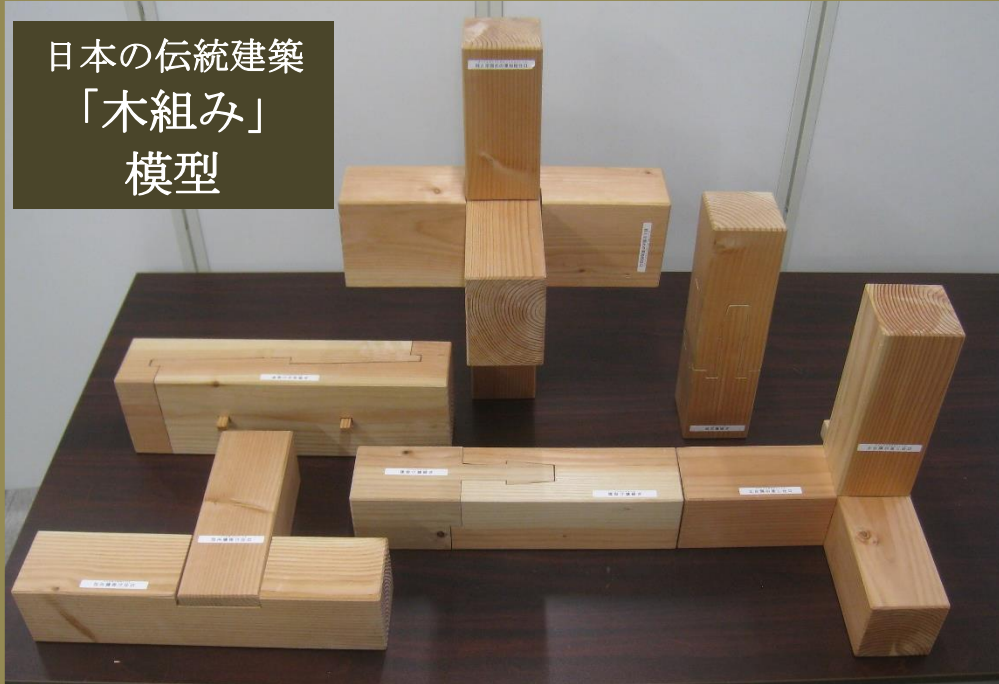
柱と足固めの車知栓仕口
