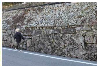
築山から転用された石垣 (香山通り)
