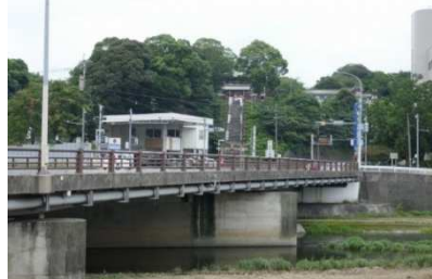
篠崎八幡宮付近(北九州市)
